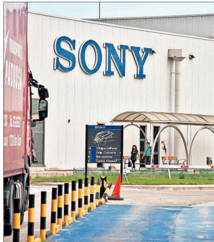
Instalaciones de la fábrica de Sony en Viladecavalls, Barcelona. / D. DATZIRA
